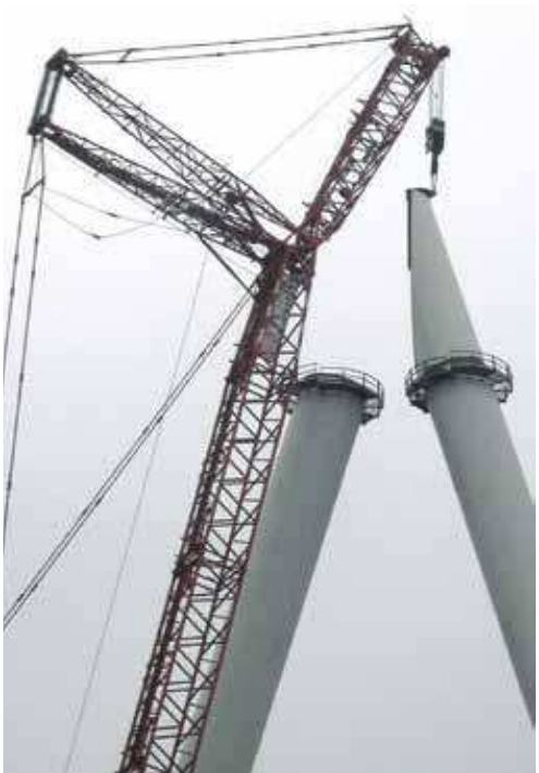
Figura 14 - Fase di sollevamento dell'elemento di estremità superiore delle gambe del pilone
