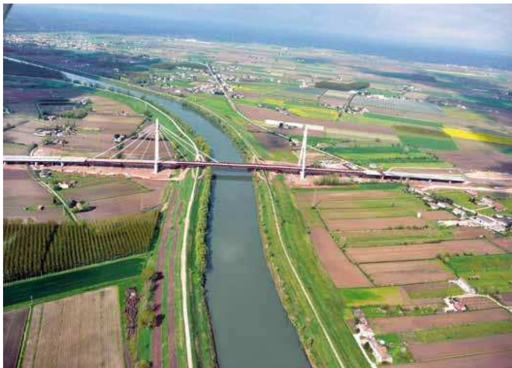
Figura 2 - Il ponte strallato in fase di montaggio degli stralli
