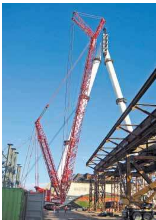
Figura 15 - Assieme autogrù da 750 t in fase di sollevamento della camera di ancoraggio
