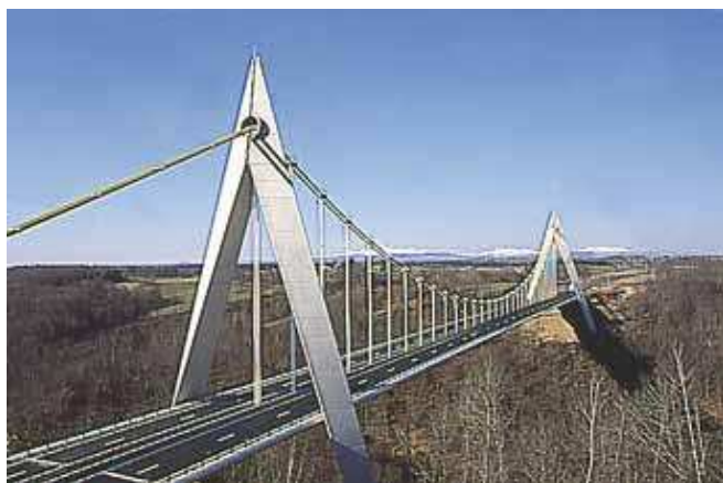
Figura 8 Il ponte Chavanon realizzato in Francia. Sfrutta nella tipologia ponte sospeso lo stesso principio utilizzato nella parte strallata del ponte sull'Adige: sola sospensione centrale dell'impalcato
